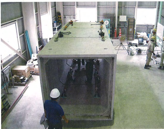
曲線施工試験 (IB50 タイプ)
