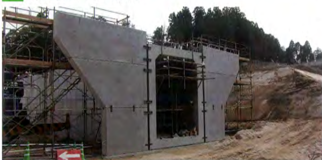
3 ブロック据付完了
