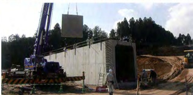
1 1段目ブロック据付
