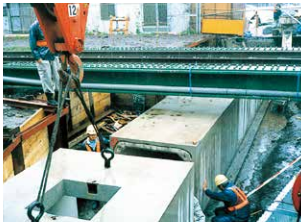
・軌道下での施工
