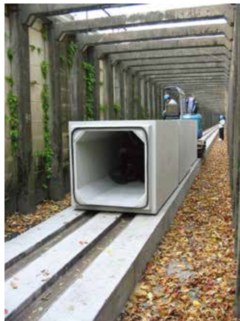
・クレーン車が使用できない狭い場所での施工
