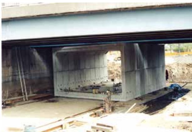
・橋梁下での施工
