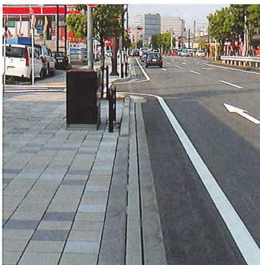
静岡県静岡市 (国道1号)
