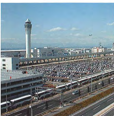
愛知県常滑市 (空港島造成)
