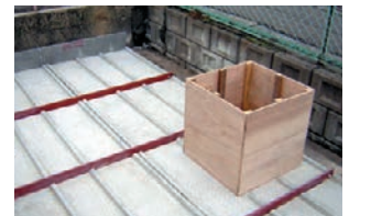
▼点検口設置状況
