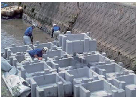
1t標準施工
