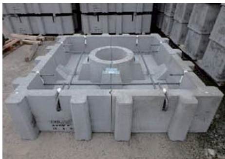
4tブロック コンクリート打込前
