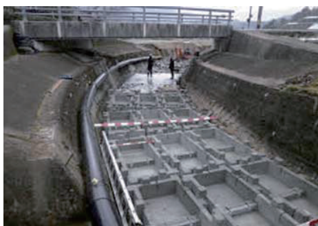
2t標準施工
