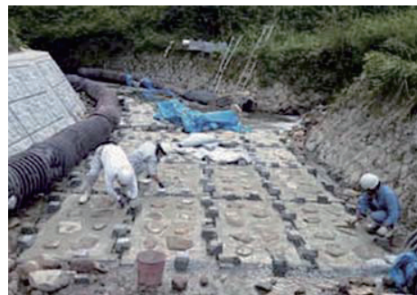
2t標準施工 植石施工
