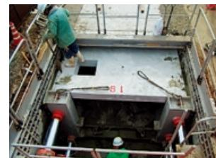
オープンシールド工法とは、上部開放型のシールド機で土留めをしながら、シールド機掘進、函体据え付け埋戻しまでの作業を連続して行い、ボックスカルバートを急速に地中に埋設する工法です。
