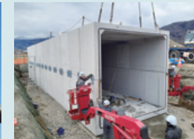
コンクリート製品据付工事
